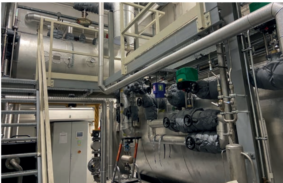
De nieuwe stoomketel verbruikt minstens 6 procent minder gas en zorgt voor 70 procent minder NOx-uitstoot.
