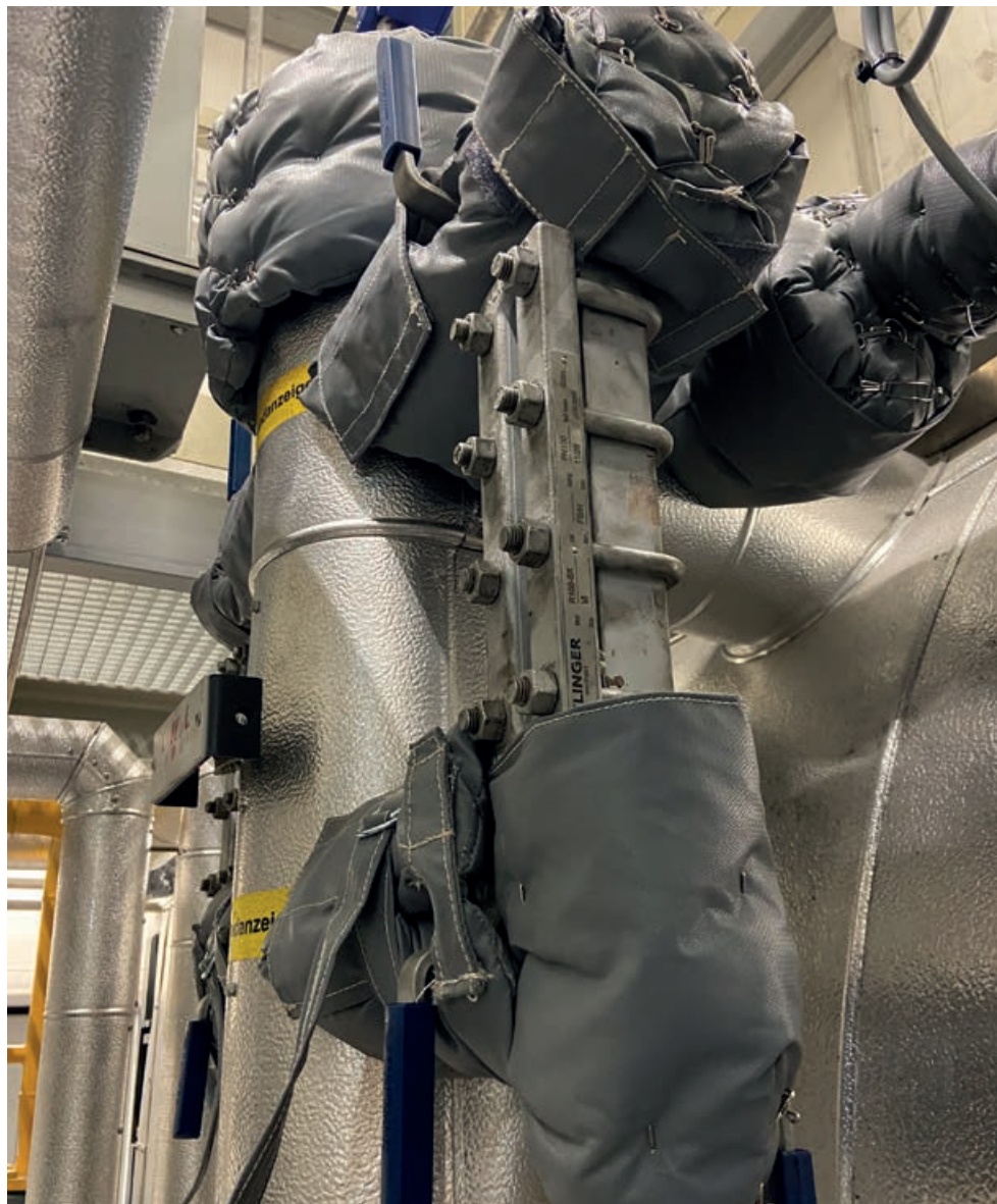
Een van de maatregelen in het verbeterplan van Vitelia was het isoleren van appendages.
